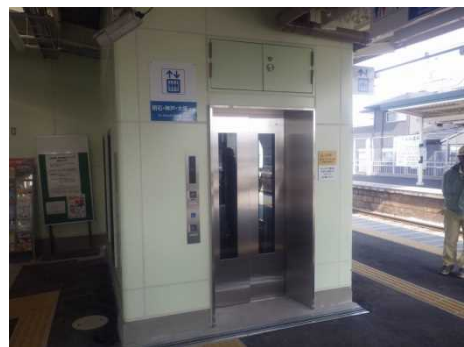
【鉄道駅舎へのエレベーター設置】
