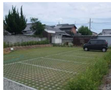
コンクリートブロックを用いた事例 （加西市）
