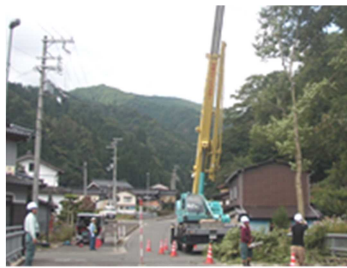
里山防災林整備 （人家裏山の危険木伐採）
