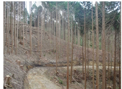
作業道を活用した間伐の推進
