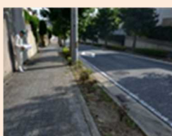
灌水不足による枯損
