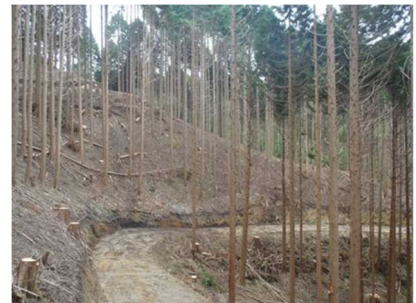
作業道を活用した間伐の推進
