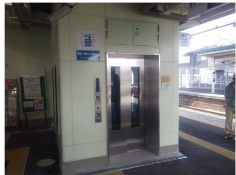
【鉄道駅舎へのエレベーター設置】
