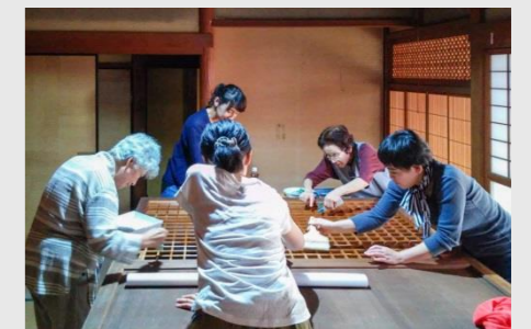
住民ボランティアによる建具の修繕（淡河宿本陣跡保存会）
