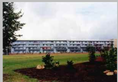
6階建てから4階建てに減築を行った住棟
