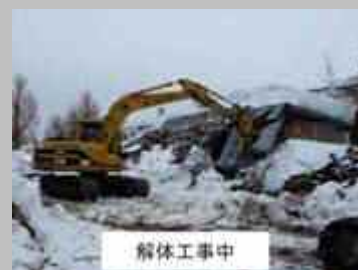
空き家解体工事
