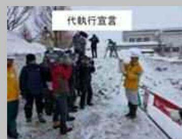
行政代執行による解体着手
