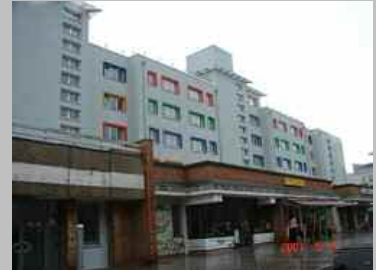
減築（上半分を撤去した建物）
