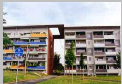
既設住棟を切断し、通り道を設け、バルコニーを増設
