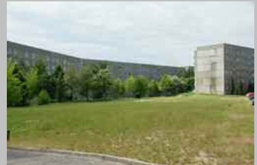
建物を撤去した後
