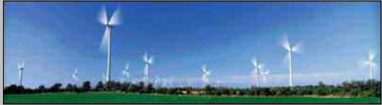
風力発電施設
