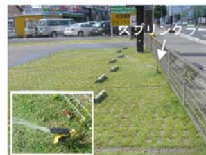
スプリンクラーを使用する場合は利用者や車両に水がかからないように配慮します。
