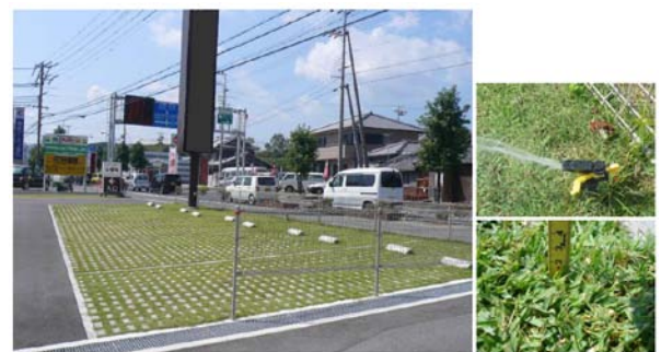
維持管理を十分に行うことで良好な芝生を保っています。（コンクリートブロック補強型）
