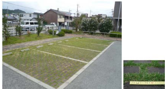
施工から6年経過しているが良好な芝生を保っています。（コンクリートブロック補強型）
