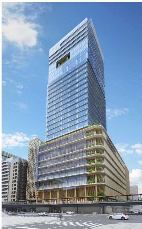
▲全体外観イメージ（南東より）
