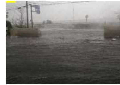
西側防潮堤からの越波状況
