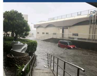
⑦ 浸水被害 (枝川浄化センター)
