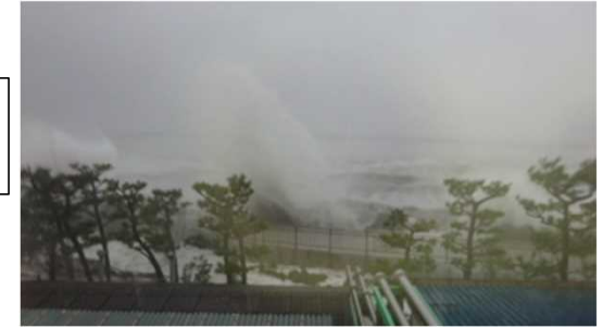
枝川浄化センター南側防潮堤からの越波状況
