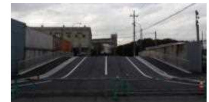
スロープ化実施済箇所
