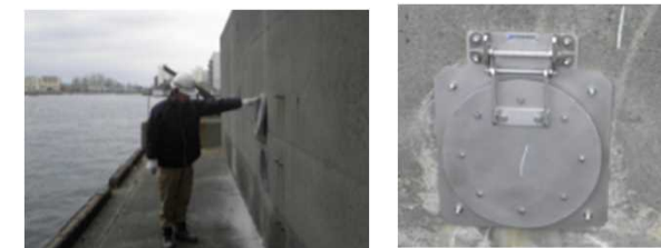
フラップゲート設置済状況
