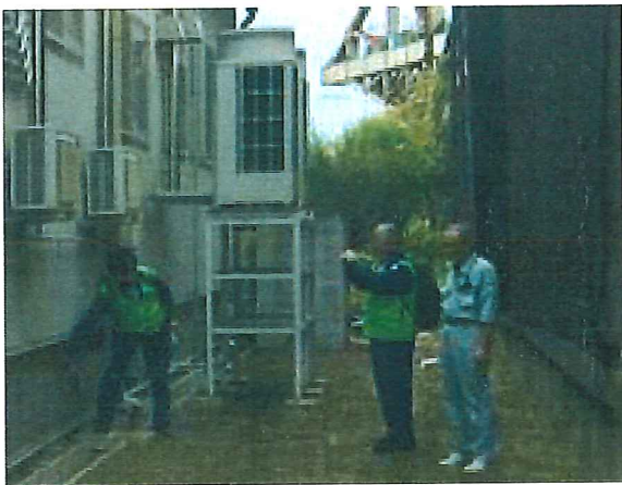
写真3：浸水痕跡調査（堺泉北港湾事務所）
