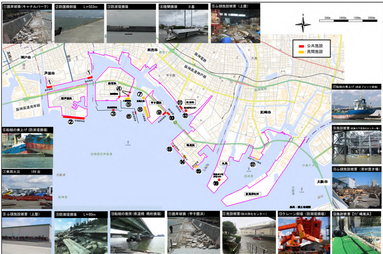
出典：兵庫県「大阪湾港湾等における高潮対策検討委員会 尼崎西宮芦屋港部会 とりまとめ」 図 2018 年台風第 21 号による尼崎西宮芦屋港の高潮被害状況
