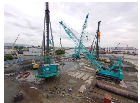
基礎工事 施工状況
