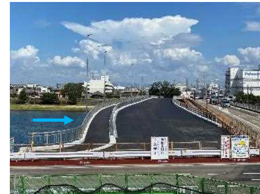
上部工施工中
