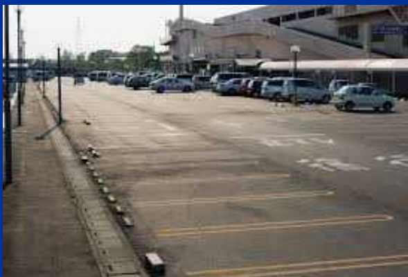
普通のアスファルトの駐車場
