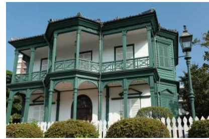
旧ハッサム住宅 [国指定重要文化財]
