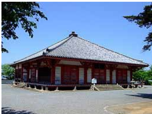
写真 1.1.1 浄土寺(小野市)
