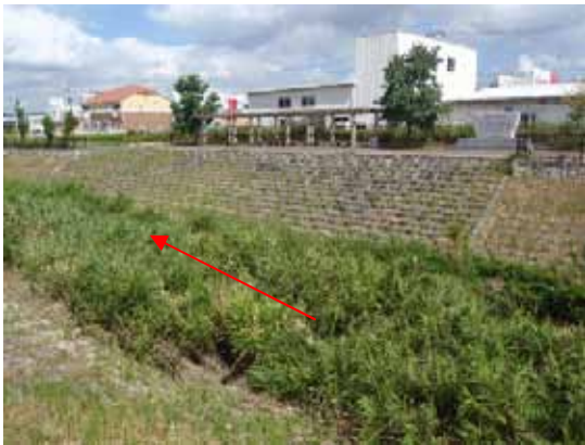
写真 2.1.5 階段護岸の整備（金剛寺谷川三木市）
