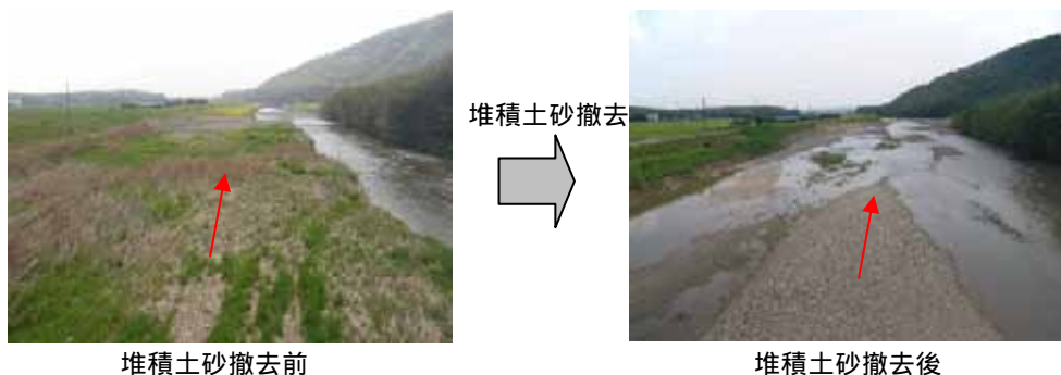
写真 2.2.1 堆積土砂撤去による河道の維持(万願寺川)
