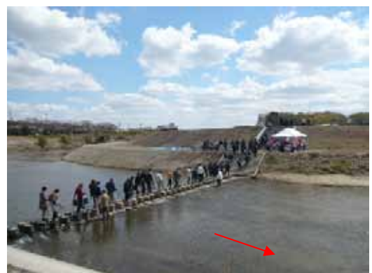
写真 2.1.4 親水型の護岸整備(東条川小野市)
