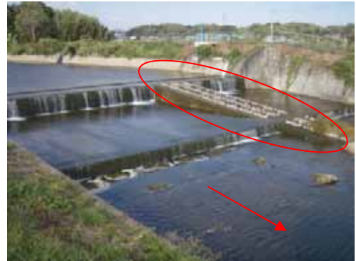
写真 2.1.1 魚道の整備(万願寺川加西市)
