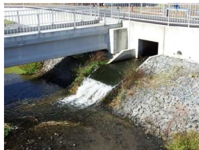
写真1.2.16 前川 市場大橋付近
