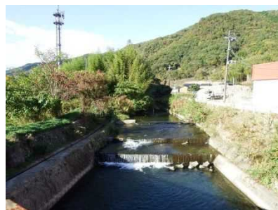
写真1.2.15 菅野川 木谷橋付近
