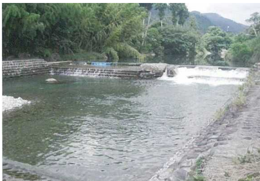
写真 1.2.19 伊沢川下町河川プール (宍粟市山崎町)
