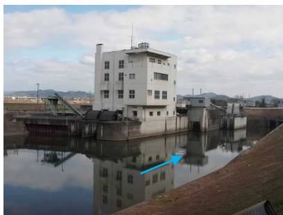
写真 1.2.9 馬路川排水機場
