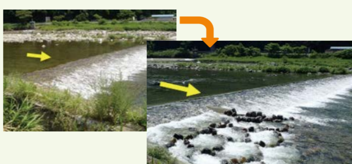
▲魚道の設置(与位樋)
