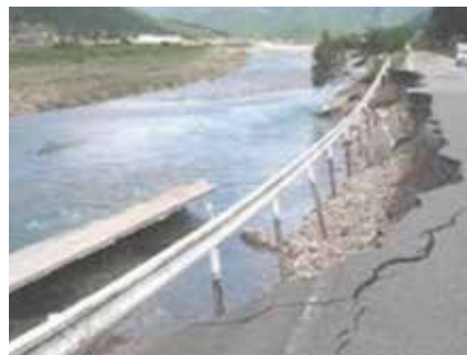
平成23年台風12号による被害 (加古川水系杉原川:多可町)
