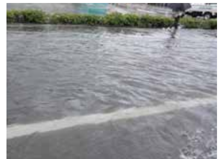
大雨で道路が冠水している様子 (神戸市内)
