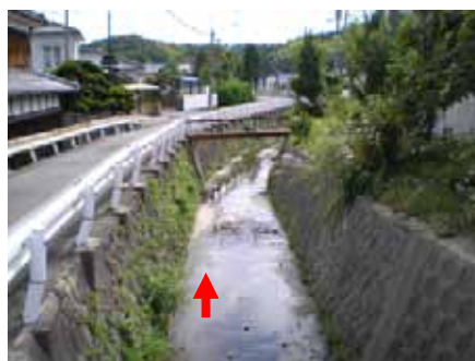
写真1.2.15 大野川上流部
