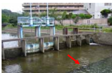
写真 1.2.4 橋井堰 かまえ からの取水
