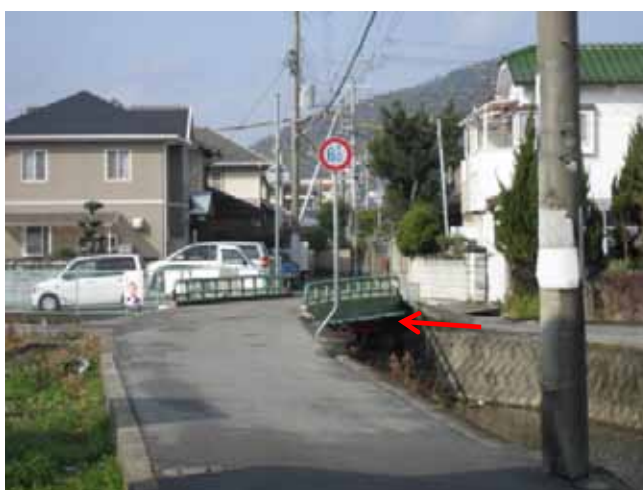
写真 1.2.2 平常時の富士才橋付近の状況
