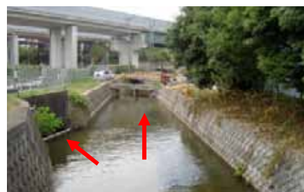
写真 1.2.5 保城・町裏 まちうら 浄水場取水口
