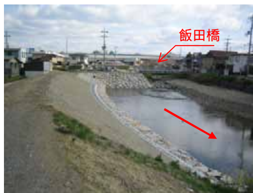
写真 1.2.3 船場川の未整備区間 (飯田橋上流)
