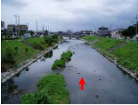
写真 1.2.9 構南橋上流の 多自然川づくり改修区間
