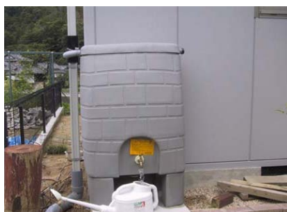
写真 2. 2. 10 雨水貯留タンク
