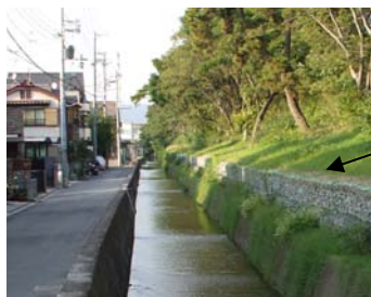
写真 4.1.1 ドレーン工法※の施工例
