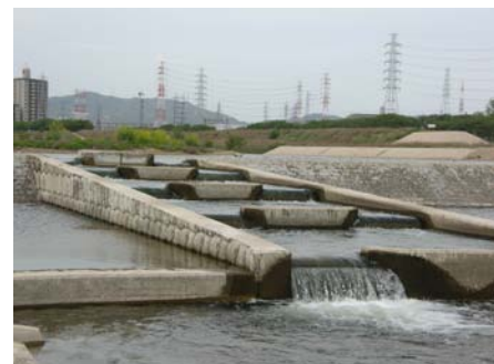
写真 2. 2. 20 床止めに設置された魚道
