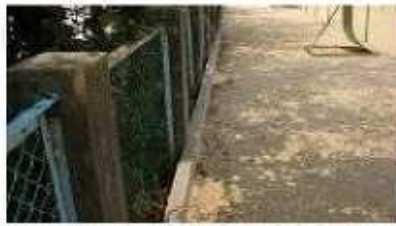
周囲に流出防止壁を設置
