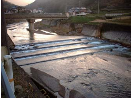
■回遊性の種の移動に配慮した横断工作物
