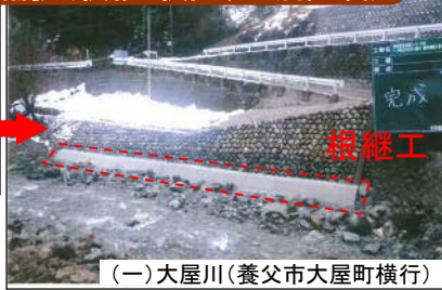
河床の低下で護岸が危険な状態でした。
