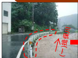
防水壁を設置しました。
