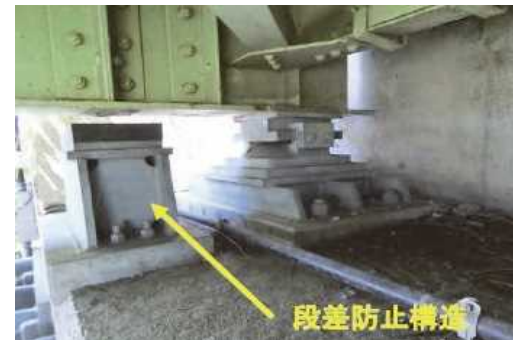
【段差防止構造の設置事例】
