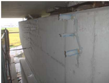
【事例】豊国第5橋
