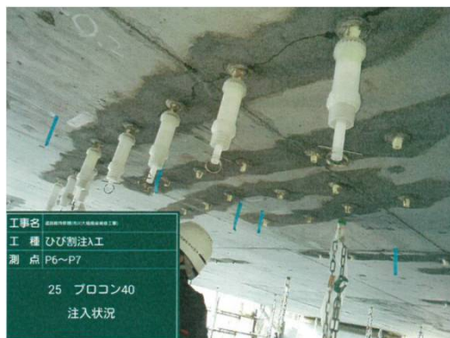
事例)市川大橋3
