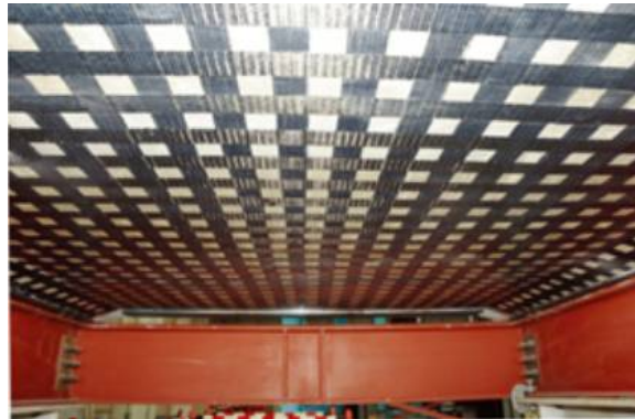
施工イメージ
