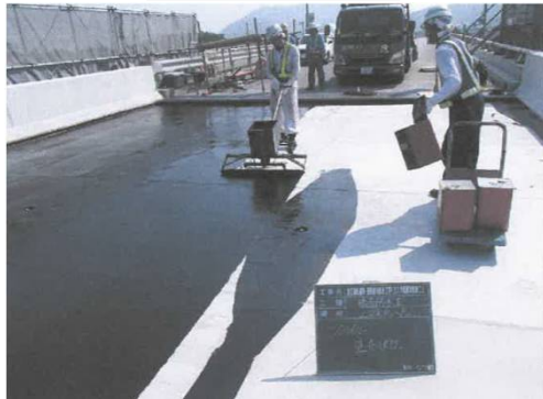
事例)市川大橋2
