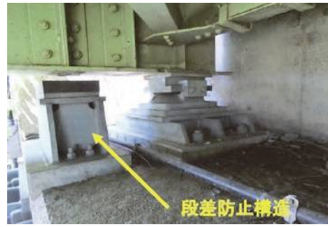
段差防止構造の設置事例
