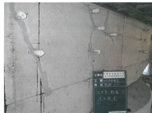
事例)佐良和高架橋
