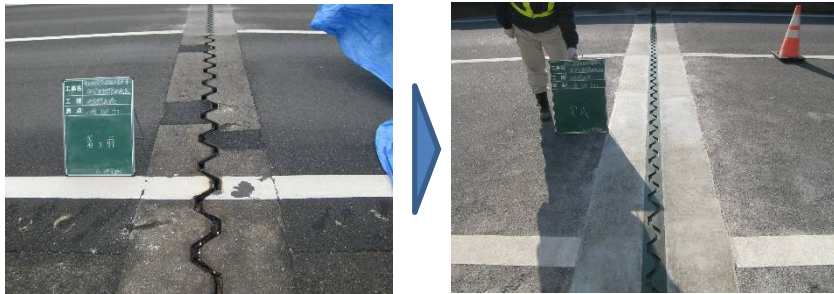
事例)第6高架橋(その3)
