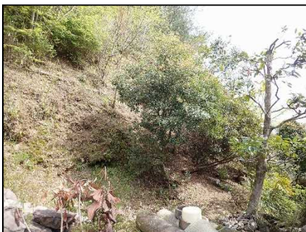
②斜面状況(人家裏)
