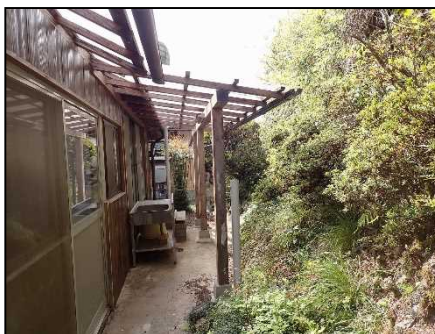
③保全対象とがけの状況
