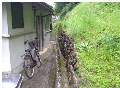
③保全対象とがけの状況
