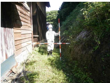
②保全対象とがけの状況
