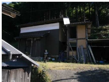
③保全対象(人家)
