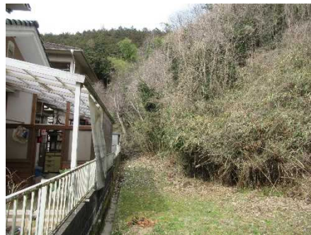
③保全対象とがけの状況
