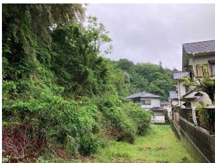
②保全対象とがけの状況
