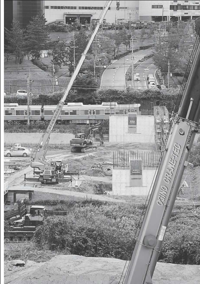
三田西インター線延長工事現場(国道176号側から三田西IC方面を望む)。JR福知山線と立体交差する橋りょうの建設が行われている=三田市溝口
