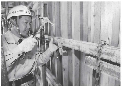
コンクリートを流し込むとき大きな力がかかるため、打設前に型枠を点検する八木繁明さん
