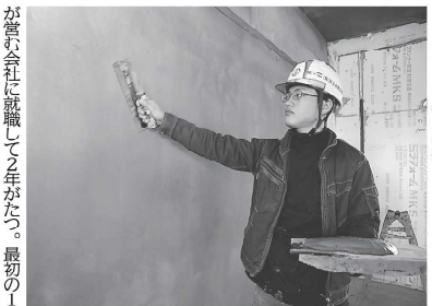
壁に修繕材を塗る川上昇悟さん。現場の左官士である父の背中を見て
