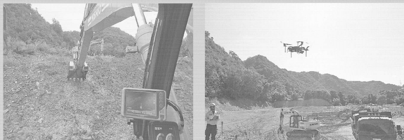
●兵庫県川遊水地整備工事(その1)におけるICT施工(ICT建機による掘削)の状況 ●兵庫県川遊水地整備工事(その2)におけるICT施工(大型ドローンによる測量)の状況
