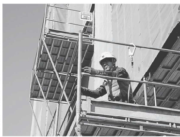
建物の高所に仮設の足場を設置する大鳥拓人さん。高所でも決して自身をこたす
