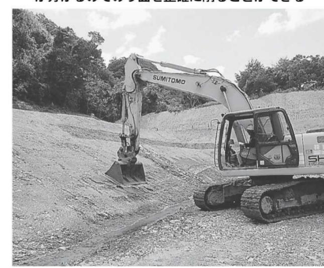
ICT(情報通信技術)の活用建設現場の生産性向上を目的とした取り組み。ドローン(小型無人機)などによる測量に基づいて3次元設計を行い、自動制御機能が搭載されたICT建機で施工することで、工期を短縮できるほか、安全性や品質の向上も期待される。
