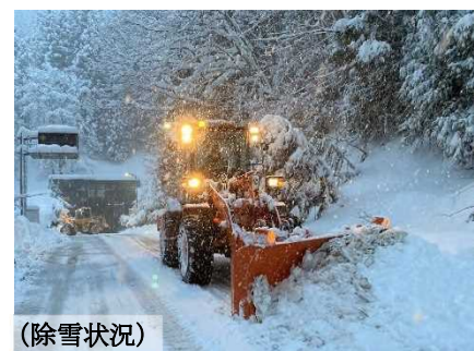
日常の維持管理(道路除雪)
