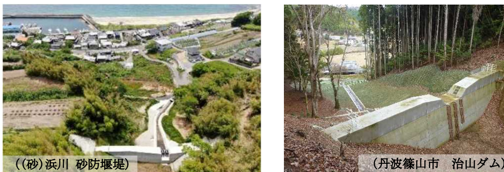
土砂災害から人家等を守る砂防堰堤・治山ダム整備
