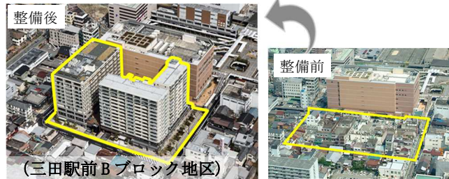
土地の高度利用と都市機能・居住環境の更新による市街地再開発事業
