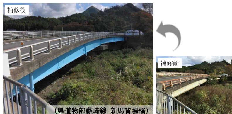
計画的・効率的な老朽化対策(橋梁補修)
