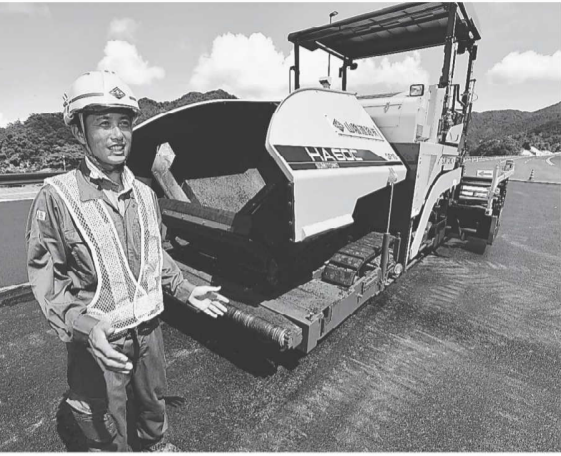
舗装工事の温度管理を常に注力するという小林辰徳氏。美方郡新温泉町対田、久々インターチェンジ
