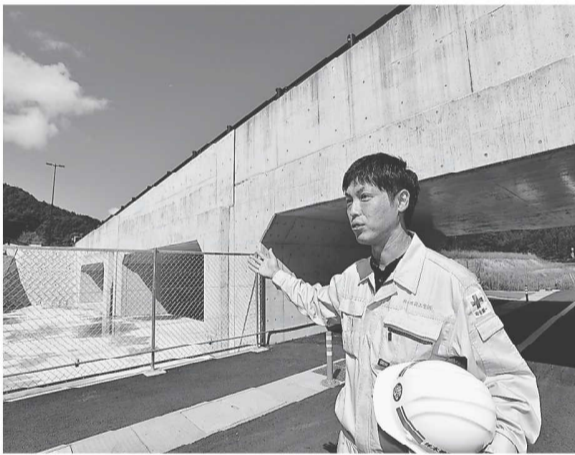
橋の下の水路について説明する椋橋信介氏。美方郡新温泉町対田、久々インターチェンジ
