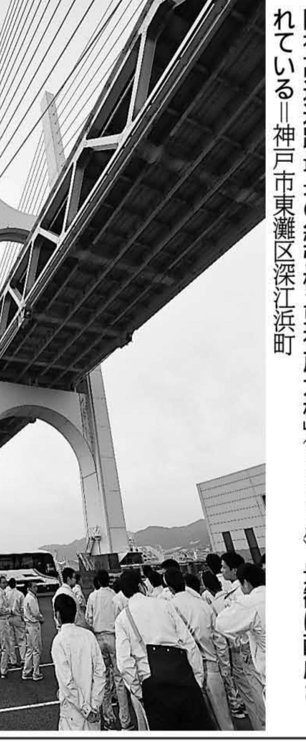
阪神高速道路最長の斜張橋「東神戸大橋」(885m)。景観に配慮されている＝神戸市東灘区深江浜町
