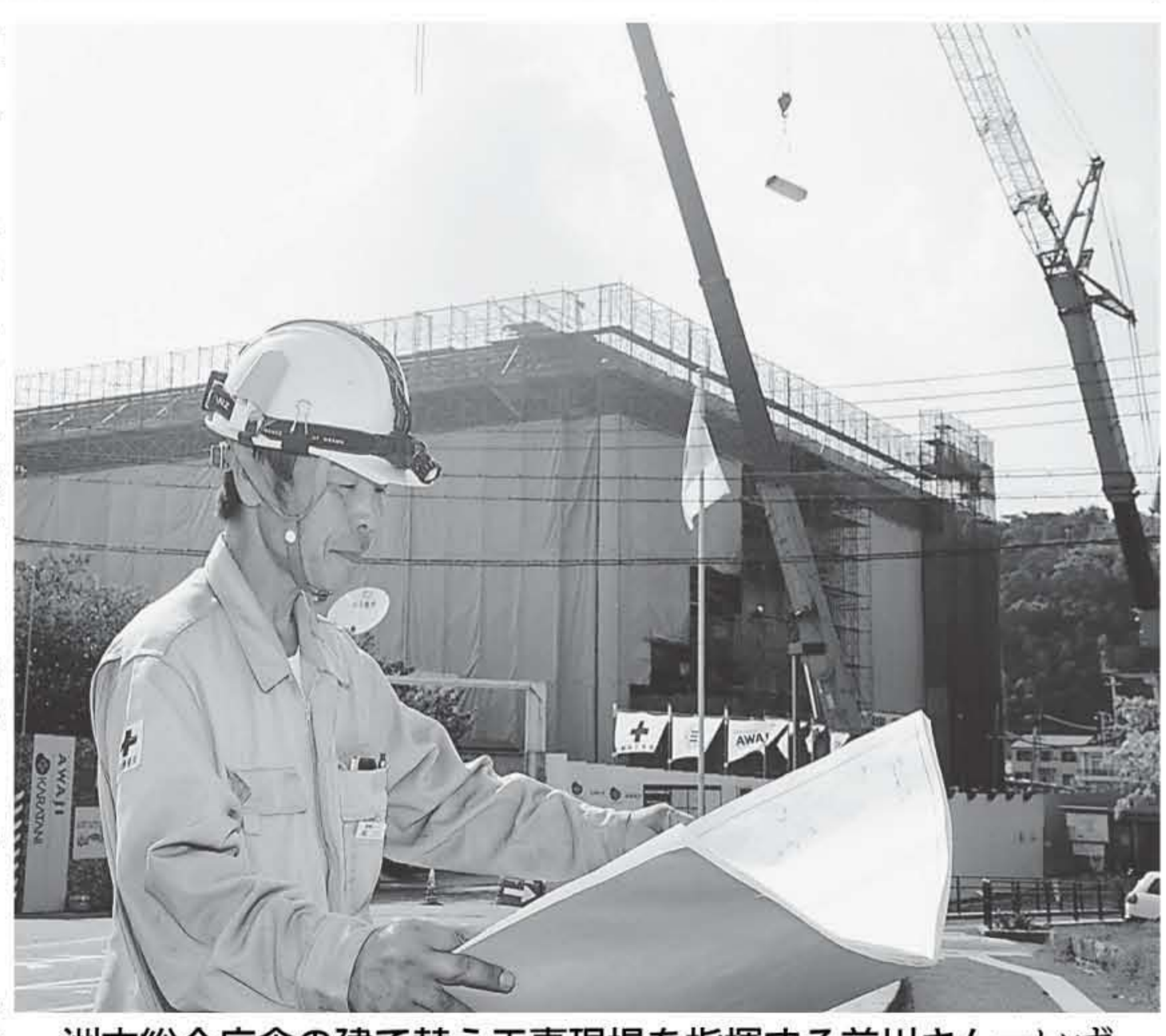
洲本総合庁舎の建て替え工事現場を指揮する前川さん(いずれも洲本市塩屋2)
