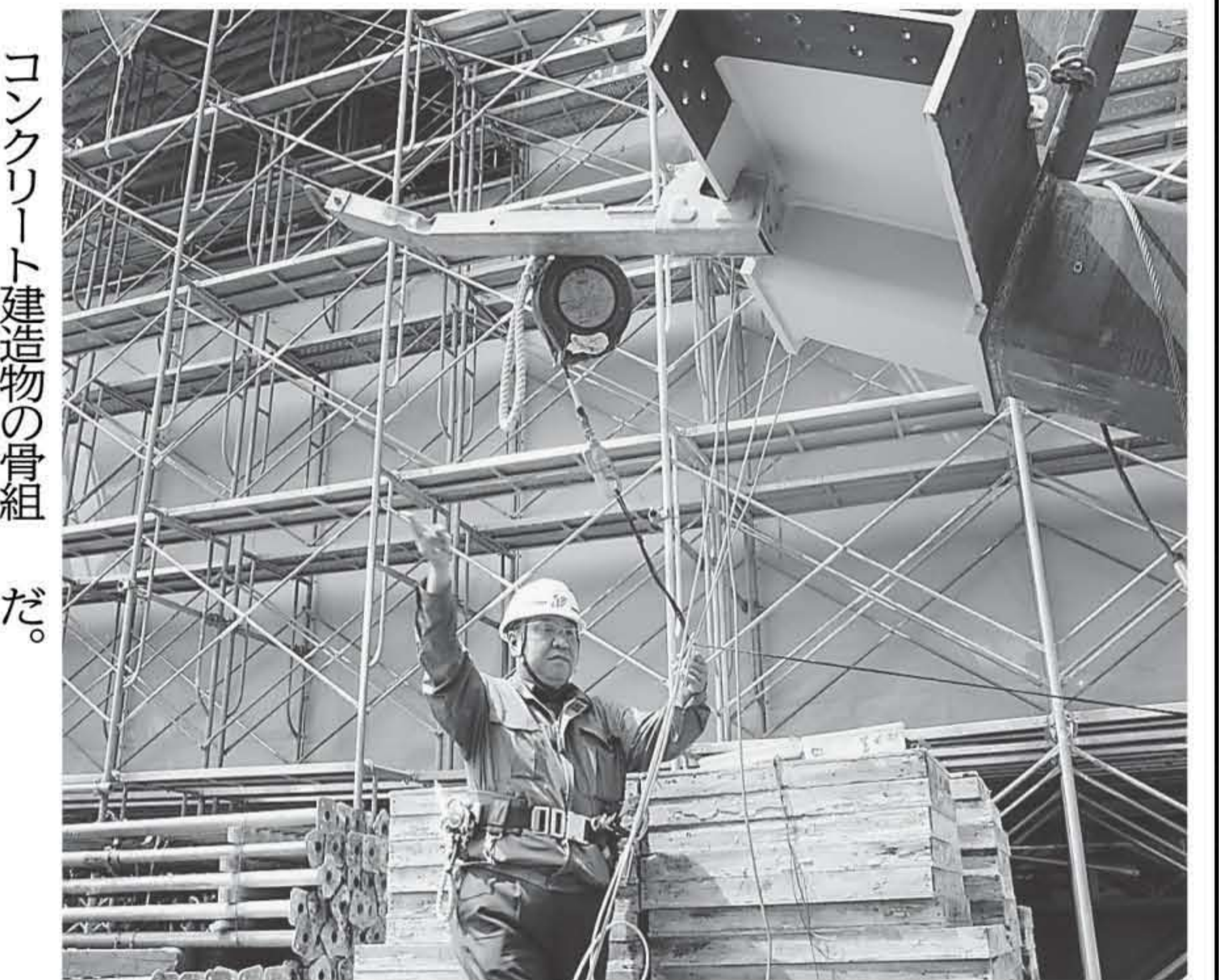
重さ1トのH形鋼を上階へ持ち上げるため、指示をオペレーターに送る今井さん
