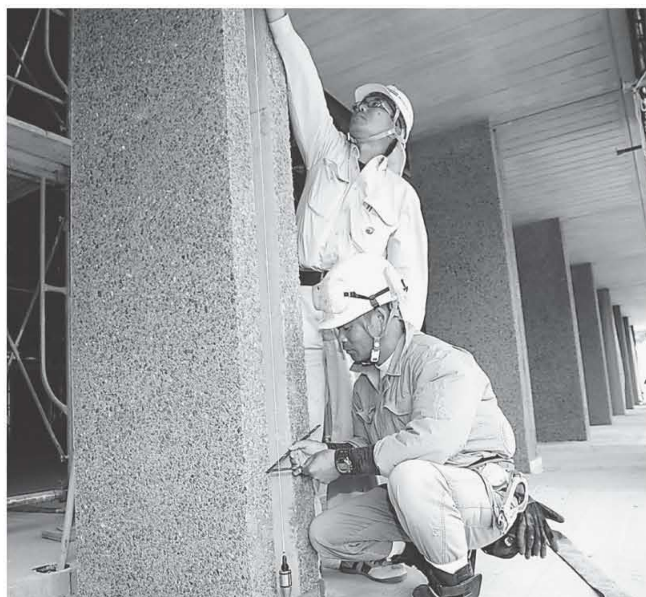
プレストレスト・コンクリート製品がまっすぐ立っているか精度確認をする藤原さん(下)
