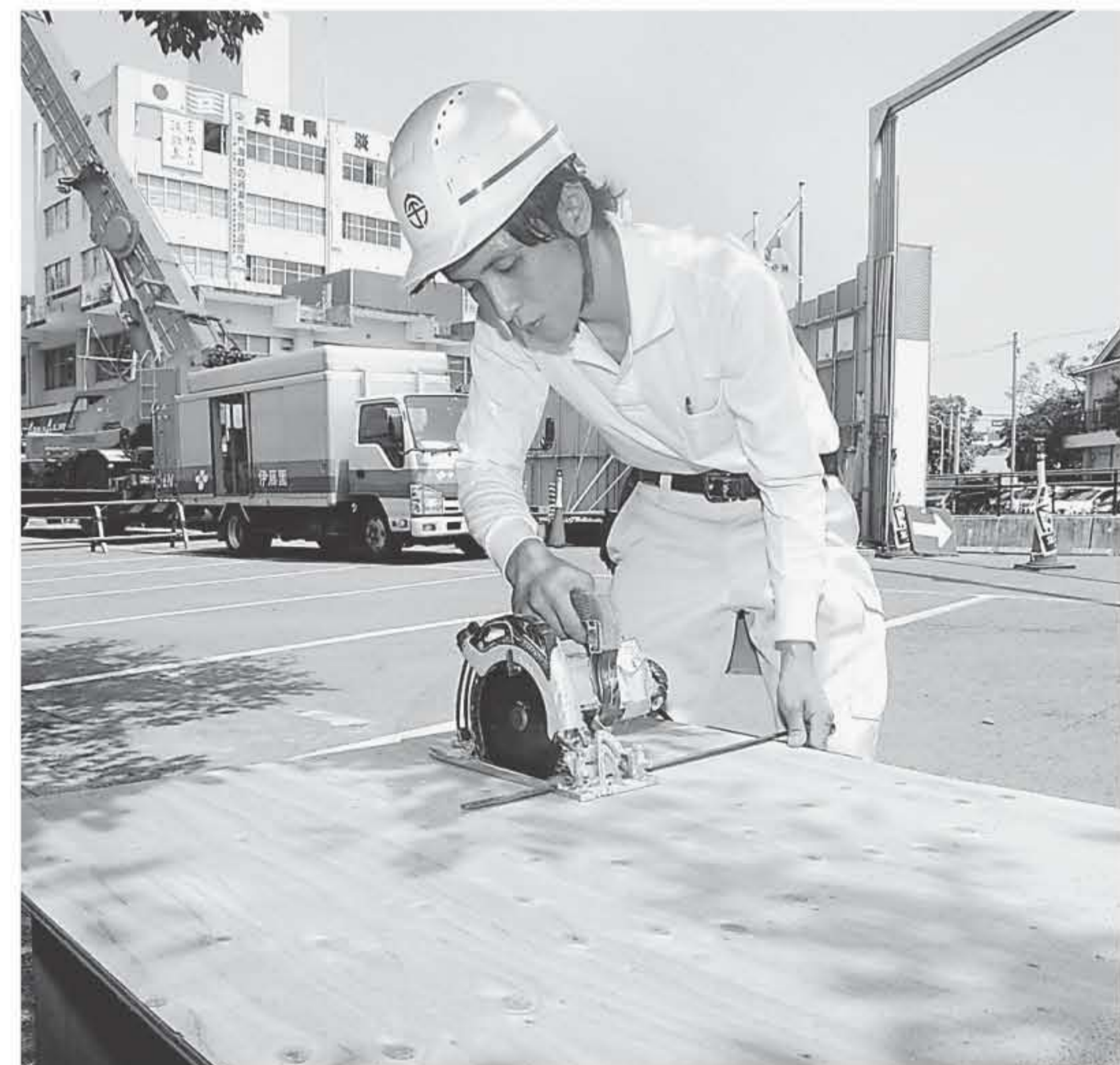
工事現場の脇で設計図面を見ながら合板を切る末盛さん
