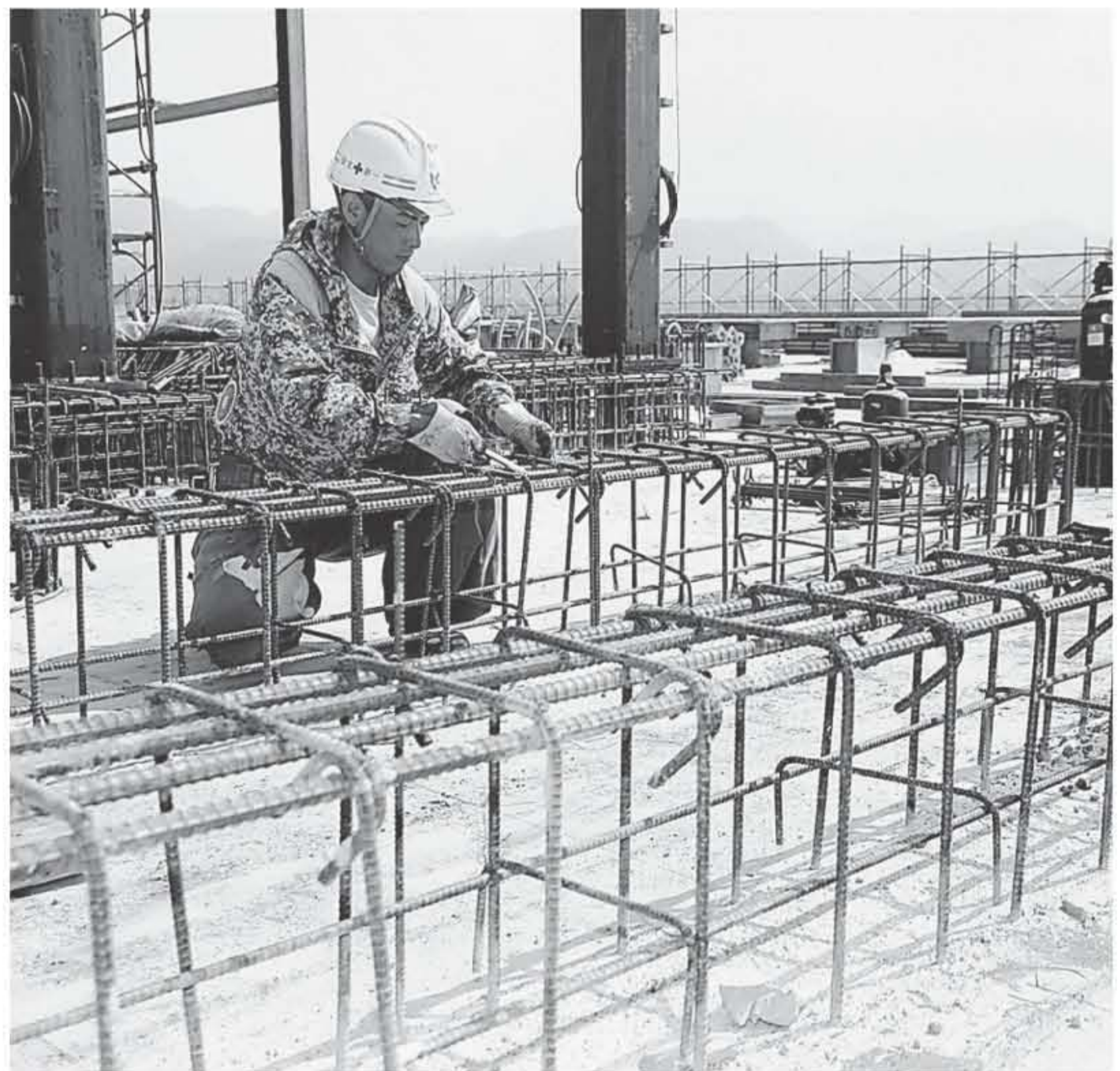
屋上で鉄筋を組み立てる財津さん
