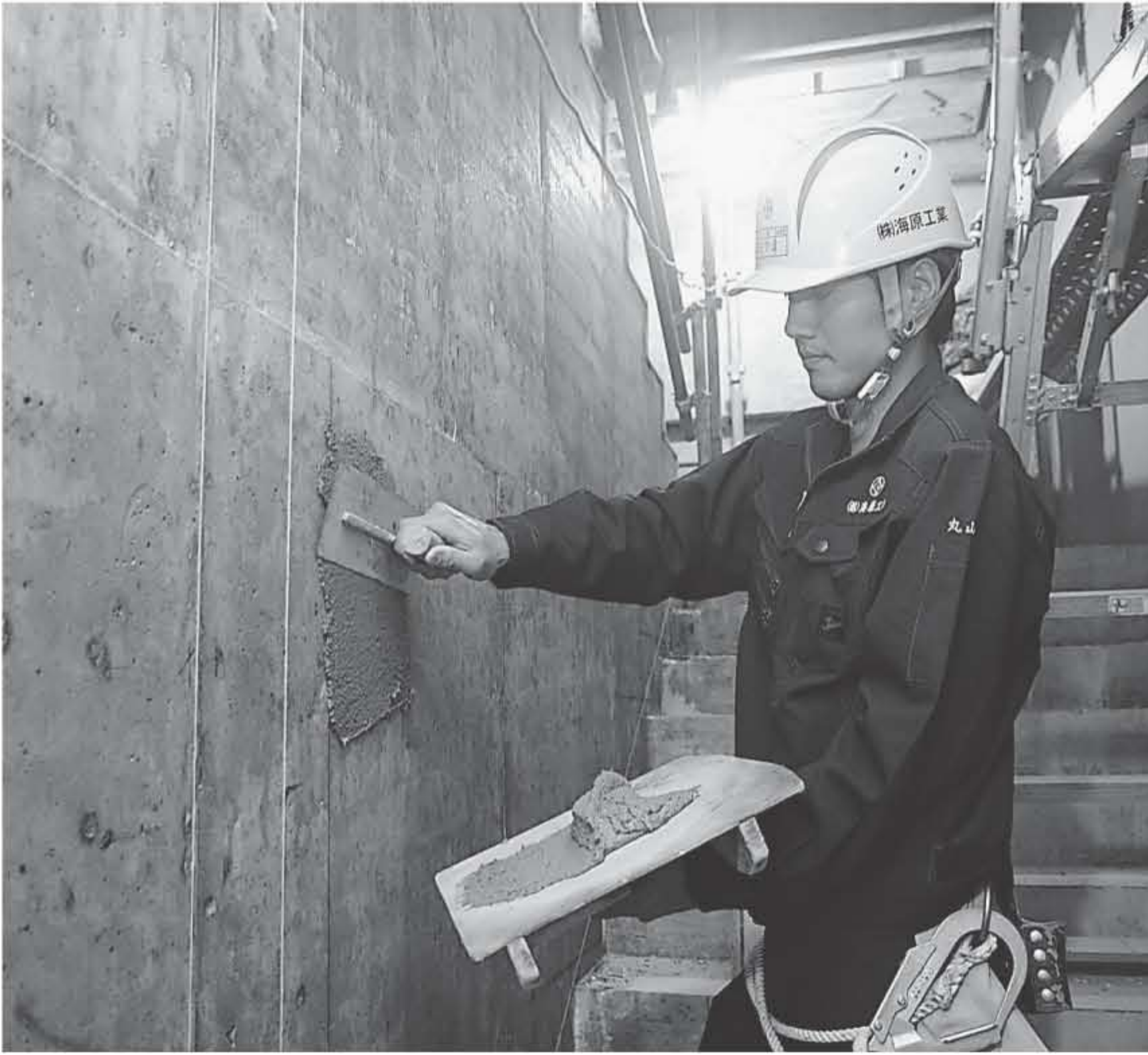
新庁舎の階段横のコンクリートの壁面を仕上げる丸山さん
