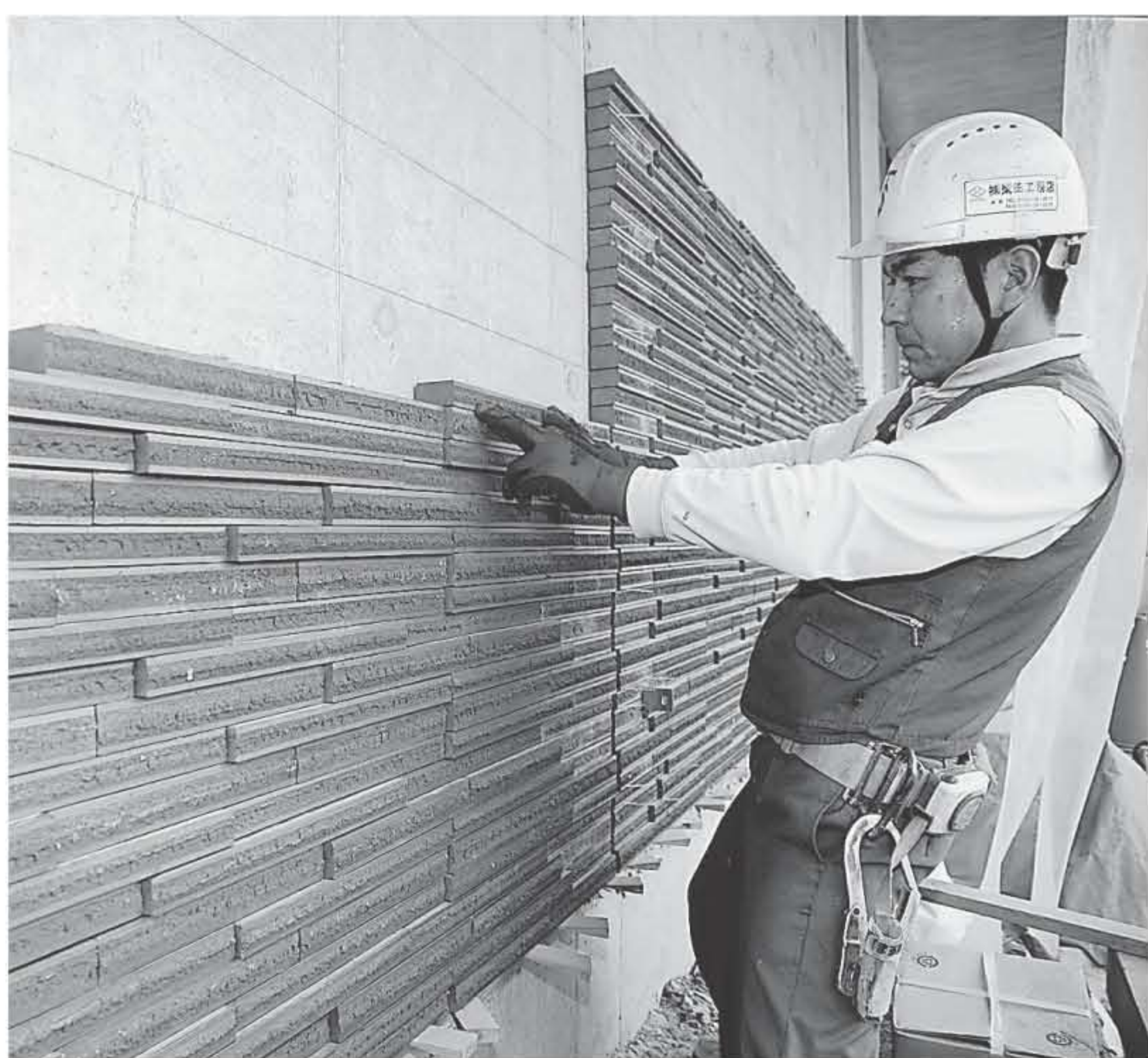
淡路瓦を模した特殊なタイルを新庁舎の外壁に貼る中田さん
