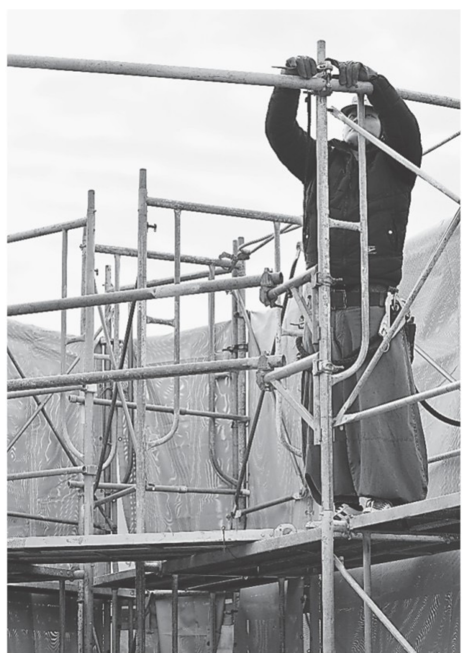
ビルの改修現場で足場を組み立てる筒井さん。いつも腰に10kgある工具をつけて作業している――姫路市内
