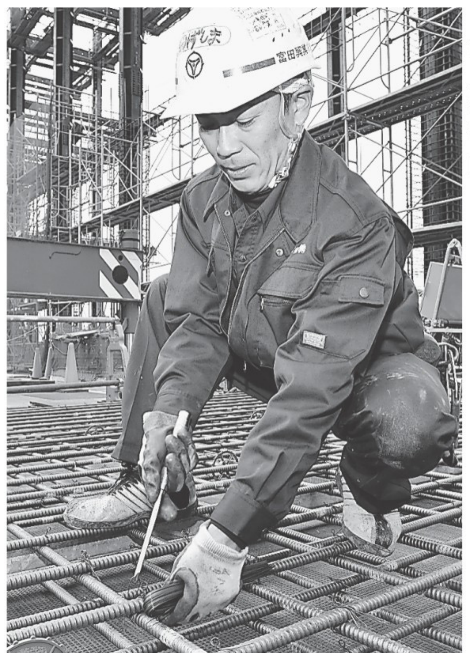
交差する鉄筋を針金で結束する水島さん。鉄筋は建物の命。神戸市内
