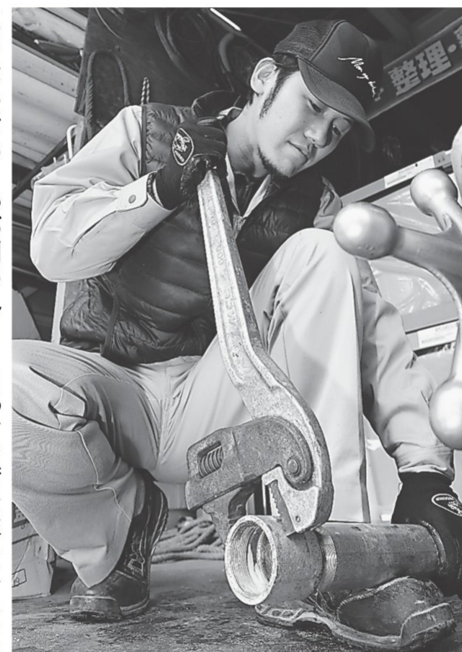
金属の管を特殊な工具でつなげる谷垣さん。緊急工事で活躍することも――養父市八鹿町
