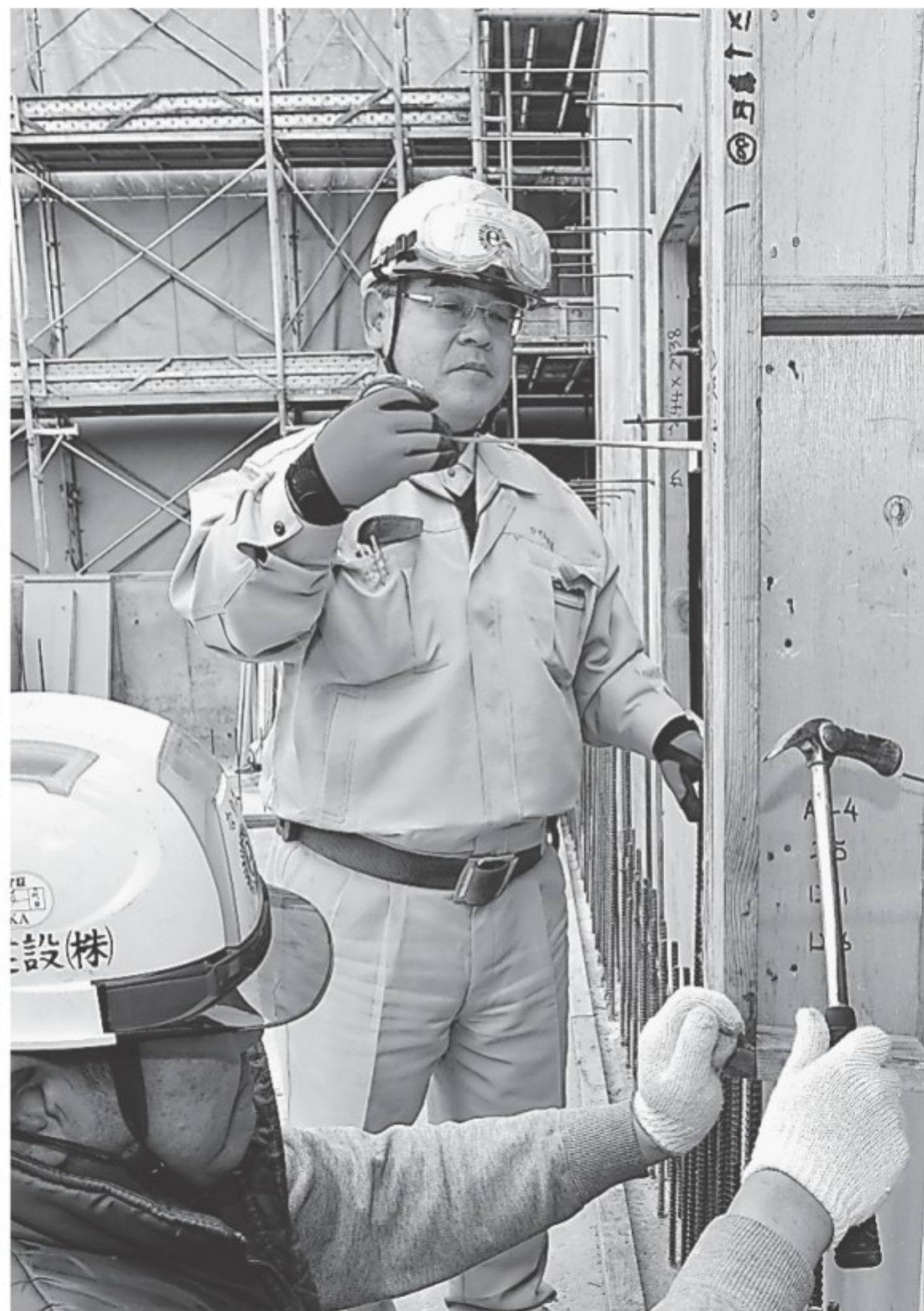
メジャーでパーツを計測する古森さん(奥)。型枠の作業は非常に細かい精度が要求される。姫路市内
