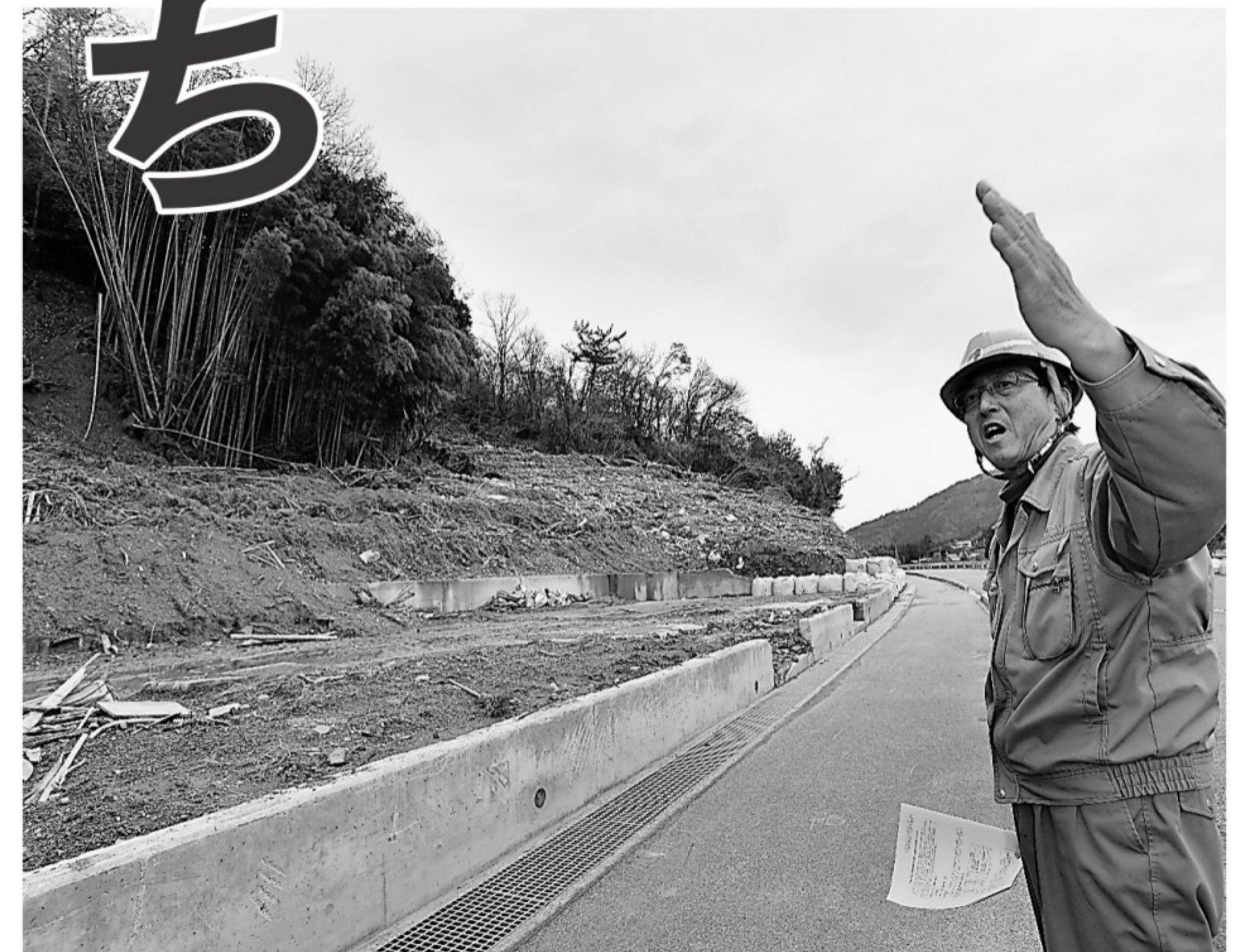
家屋が全壊した現場跡。左の斜面で崖が崩れ民家を押しつぶした。道路まで土砂が押し寄せ通行不能となった＝丹波市市島町徳尾
