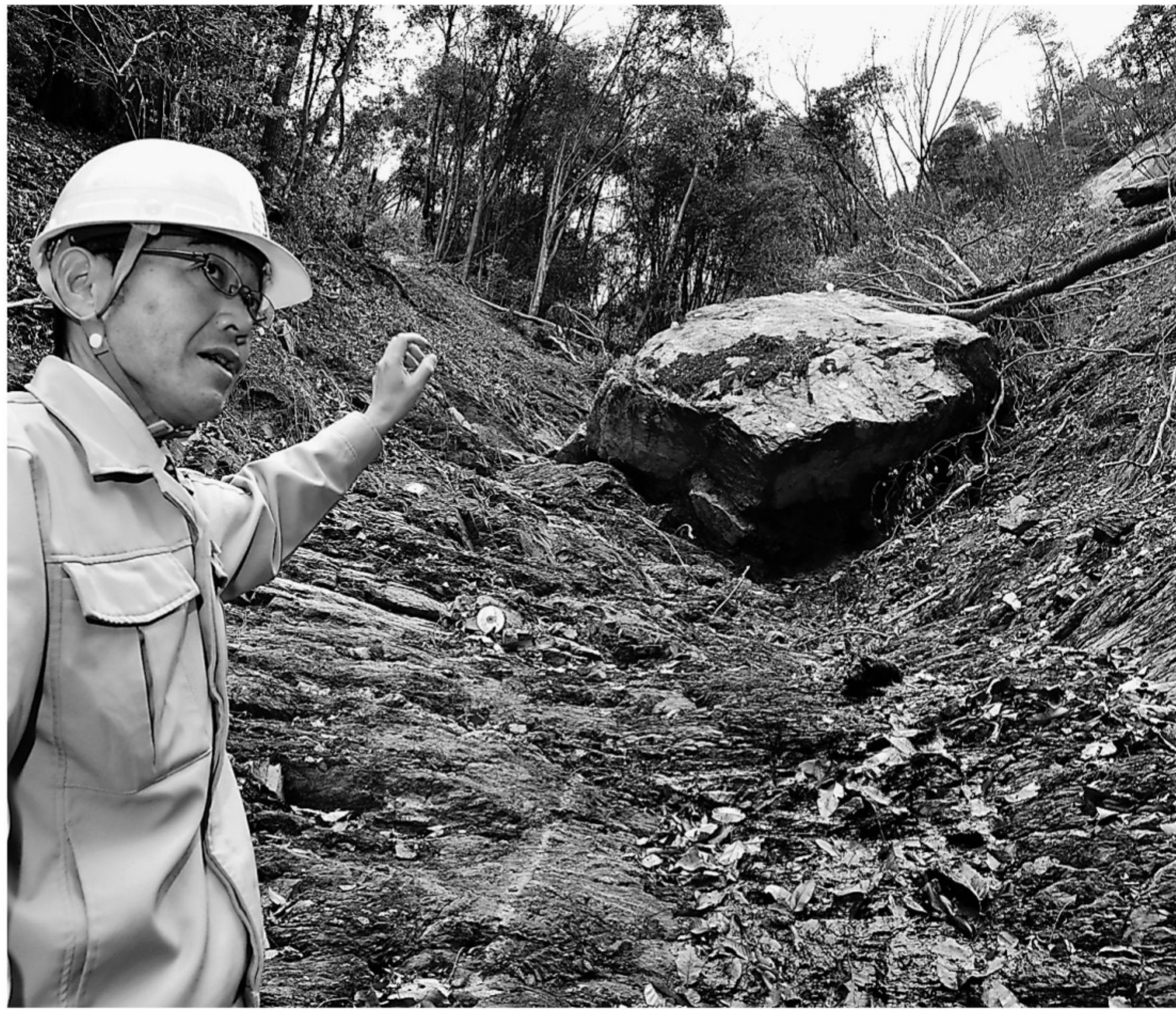
土砂流出により斜面に推定200トンの巨石が出現。監視カメラ、動きを感知するセンサーを取り付け常時監視している＝丹波市市島町徳尾
