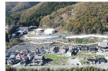
五十波地区 急傾斜地崩壊防止施設 (宍粟市)
