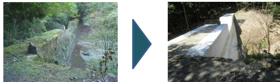
(砂)西山堰堤(姫路市) (堰堤改良)
