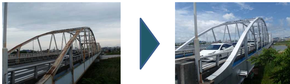
(一)白浜姫路停車場線 阿保橋(姫路市) (橋梁補修)
