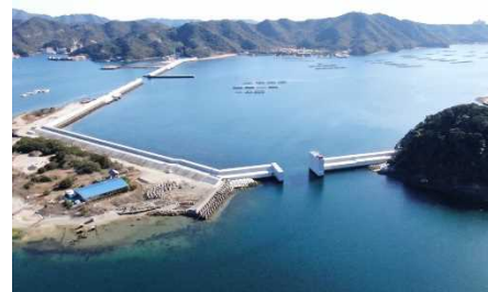
福良港(南あわじ市) 湾口防波堤
