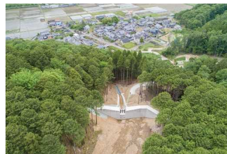
本郷谷川砂防堰堤 (養父市)
