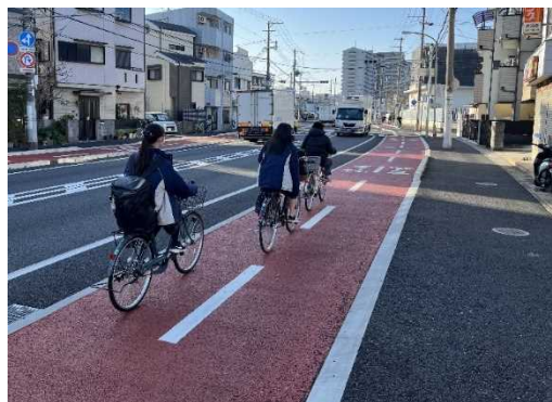
県道尼崎停車場線(尼崎市) 自転車道整備(ベンガラ)
