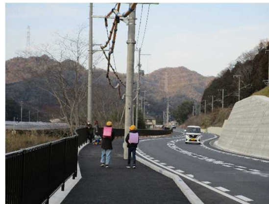
県道多可柏原線(丹波市) (歩道整備)
