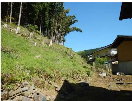
②斜面状況(人家裏)
