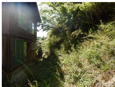
③保全対象とがけの状況
