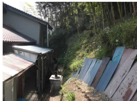
③保全対象とがけの状況
