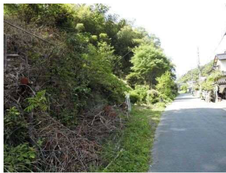
③斜面状況(中間部)
