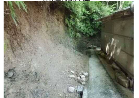
⑤斜面状況
