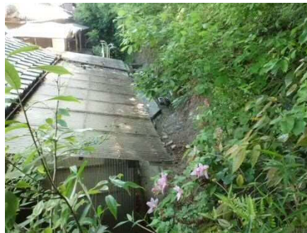
③保全対象とがけの状況
