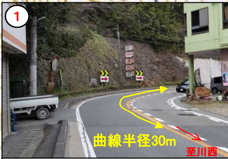
線形不良(急カーブ)
