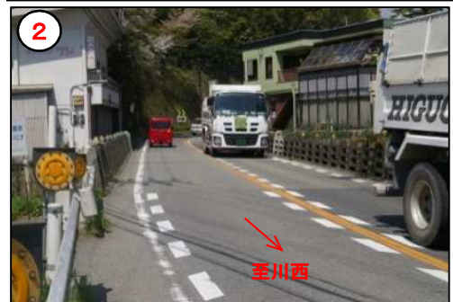
幅員狭小・歩道未整備区間
