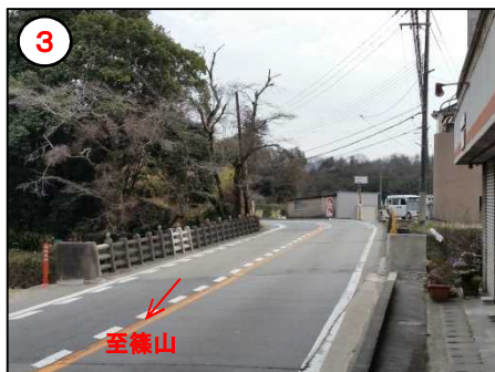
幅員狭小・歩道未整備区間
