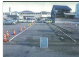
アスファルト舗装
