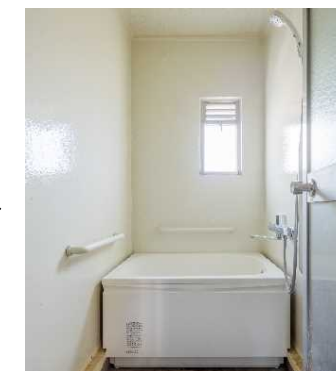
浴室の改修工事 (手すり設置、浴槽入替え)
