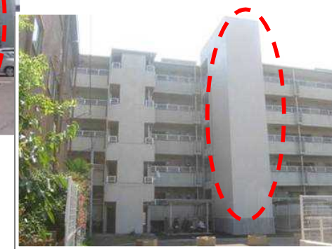
EVの設置工事
