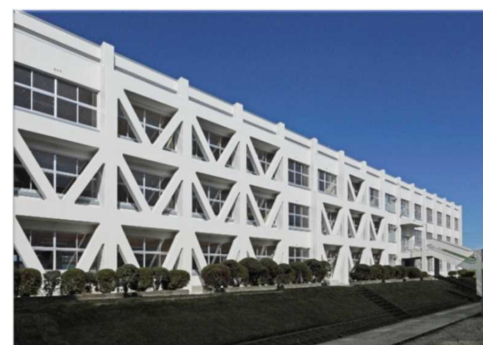
洲本実業高校耐震改修
